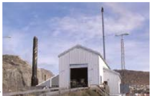
Forbrændingsanlæg i Qaqortoq, Kujataamiu 19. okt 2017
